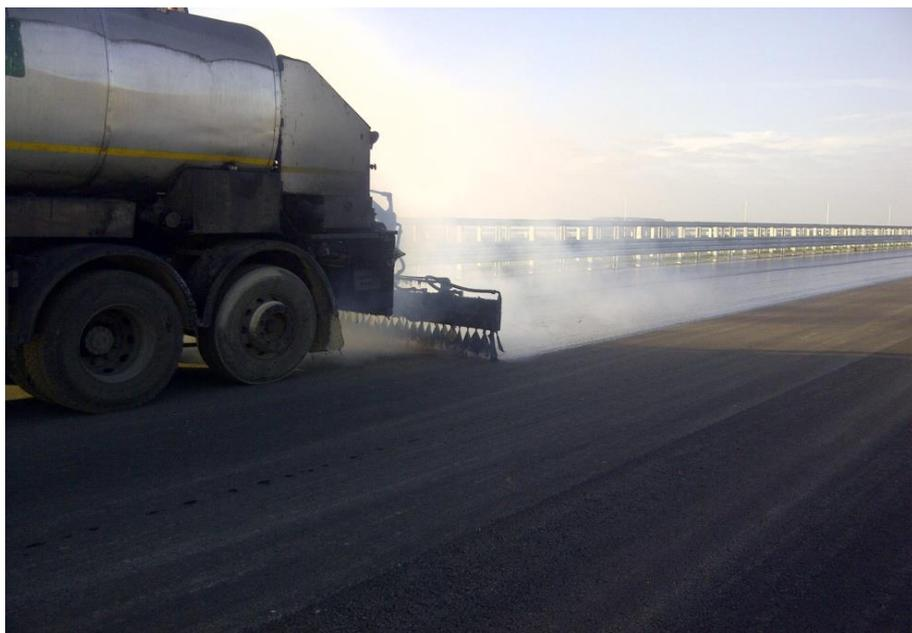
L'**emulsione bituminosa acida**, prodotta schiumando il bitume mediante iniezione di acqua all'impianto di Lonato d/G, ha la sola funzione di aggrappante.
