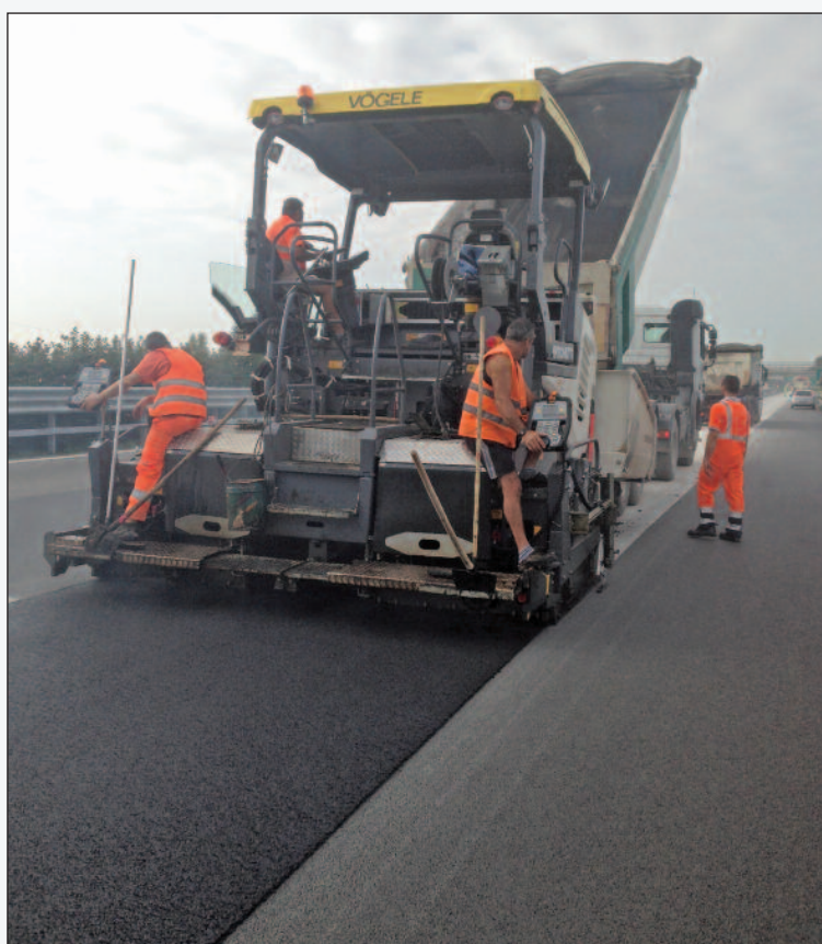
1. La stesa di conglomerato bituminoso sperimentale in sede autostradale (222+000 dell'ACP - Autostrade Centro Padane SpA)
